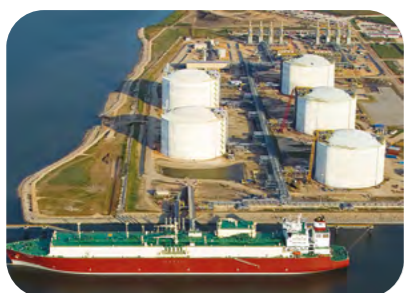
Golden Pass LNG Texas, USA
